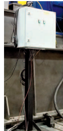
In der Signalbox werden die Kabel der Sensoren gesammelt.
